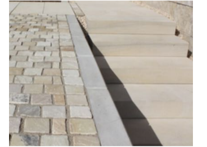
Rampenmaterial Sandsteinpflaster 10 x 20 cm Rutschhemmung >=R11
